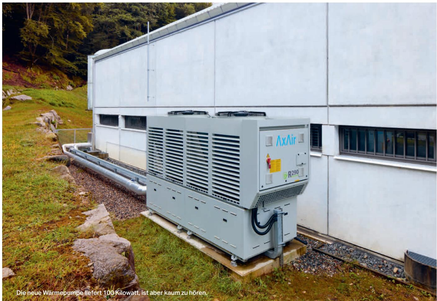
Die neue Wärmepumpe liefert 100 Kilowatt, ist aber kaum zu hören.
