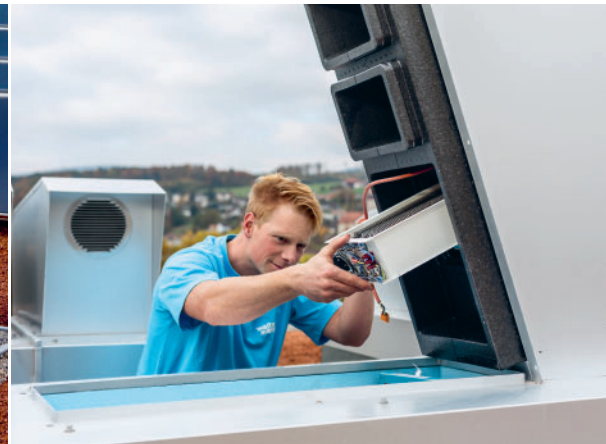
Zentrale Wartung auf dem Dach
