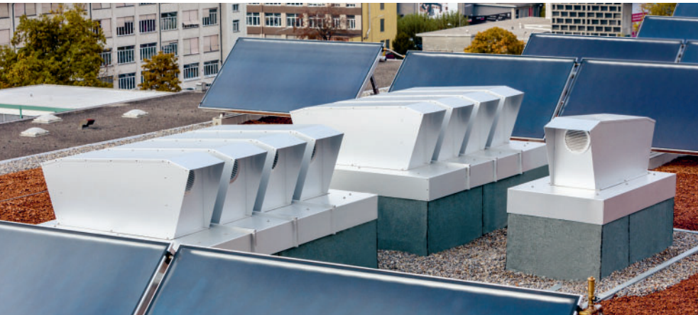
Zentrale Platzierung der einzelnen Wohneinheiten auf dem Dach
