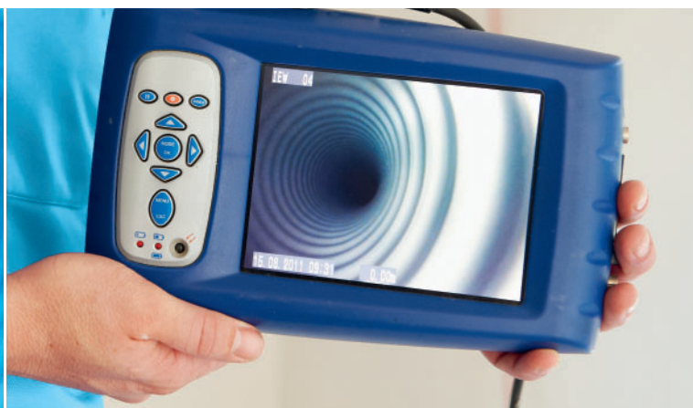
Optische Kontrolle mit Kanalkamera
