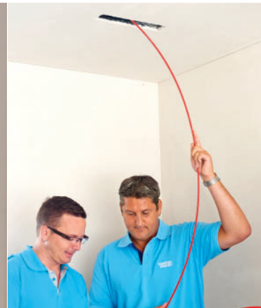
Kontrolle und Inbetriebnahme der Anlage durch Spezialisten von Walter Meier
