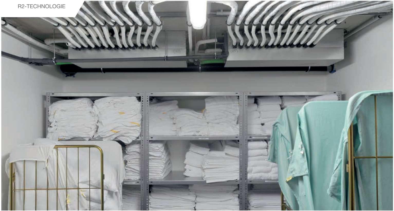
Nehmen keinen Platz weg: Die BC-Controller zur bedarfsgerechten Verteilung der Energie wurden einfach unter der Decke im Wäscheraum montiert.
